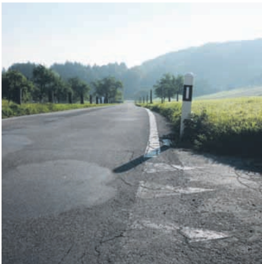
Die Riedstrasse soll komplett saniert und verbreitert werden.
